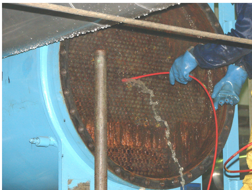
Figura 4.12 – Limpeza dos tubos do condensador por meio de hidrojateamento
