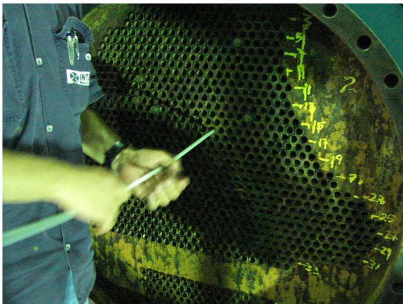
Figura 4.10 – Medição eletrônica de espessura dos tubos do condensador
